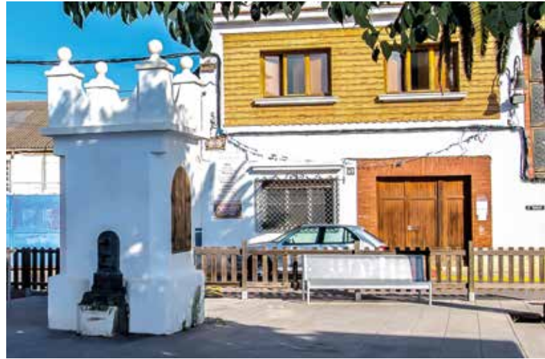
Edificio del Centre Maternal en l'actualitat.
