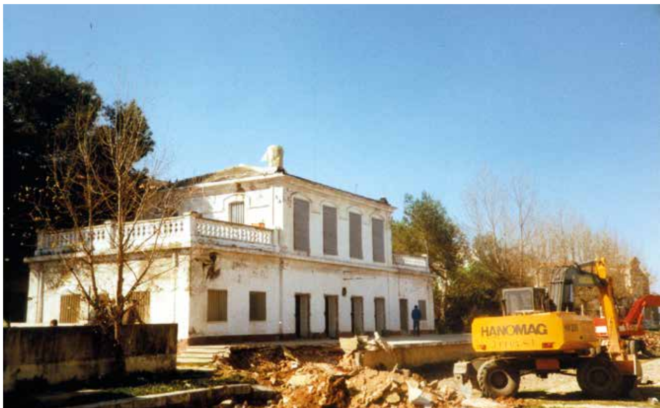
Març de 1989. Antiga Estació. Les necessitats urbanístiques del poble van fer que s'iniciaren les obres de demolició de l'antiga estació del trenet. En la foto es veu com les màquines retroexcavadores comencen a retirar l'andana.
